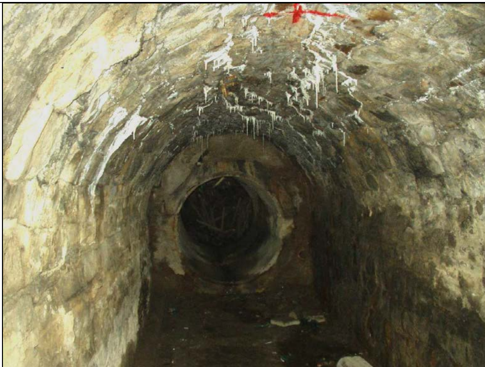
Obr. č. 7 - pohled na vyústění trouby do propustku na jeho levém konci. Ve stropě jsou patrné usazeniny ze zatékající vody.
