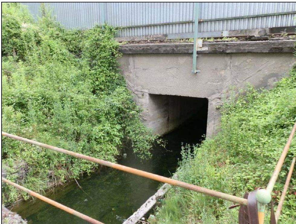
Obr. č. 1 - pohled na objekt zprava, na této straně je z propustku výtok. Z důvodu nefunkčního navazujícího odvádění povrchové vody v areálu cementárny je zde trvale voda v této úrovni, tj. cca 0,4 m nade dnem propustku na pravé straně.
