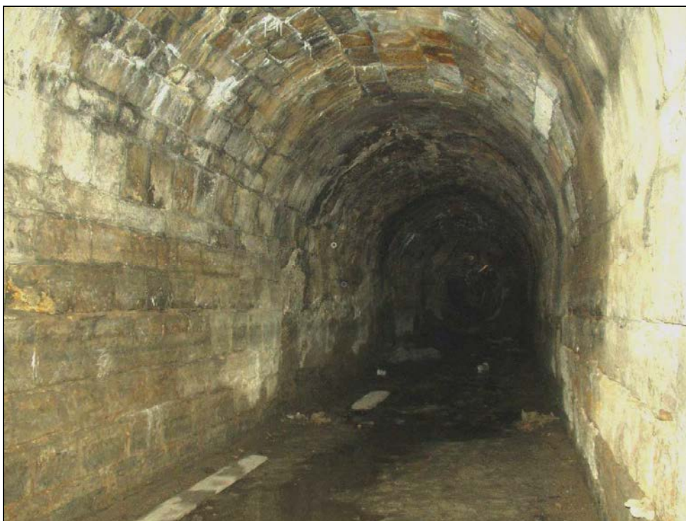
Obr. č. 6 - pohled od pravého čela na levou část propustku. Do zdiva spodní stavby a klenby silné zatéká.
