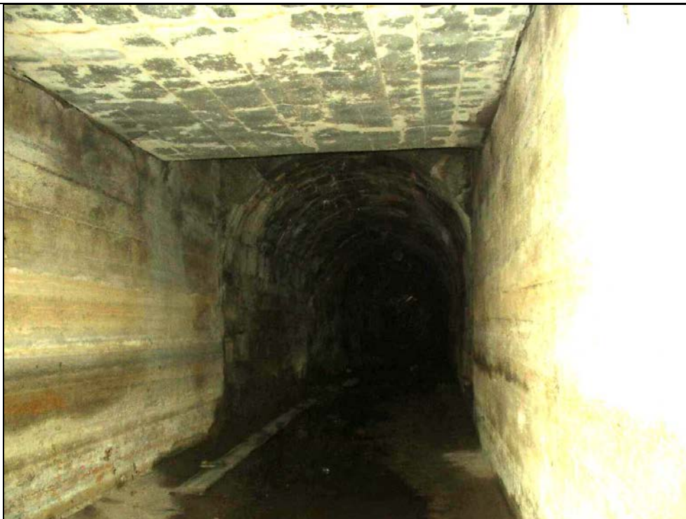
Obr. č. 5 - pohled od pravého čela na levou část propustku, kde je spodní stavba a klenba z kamenného zdiva
