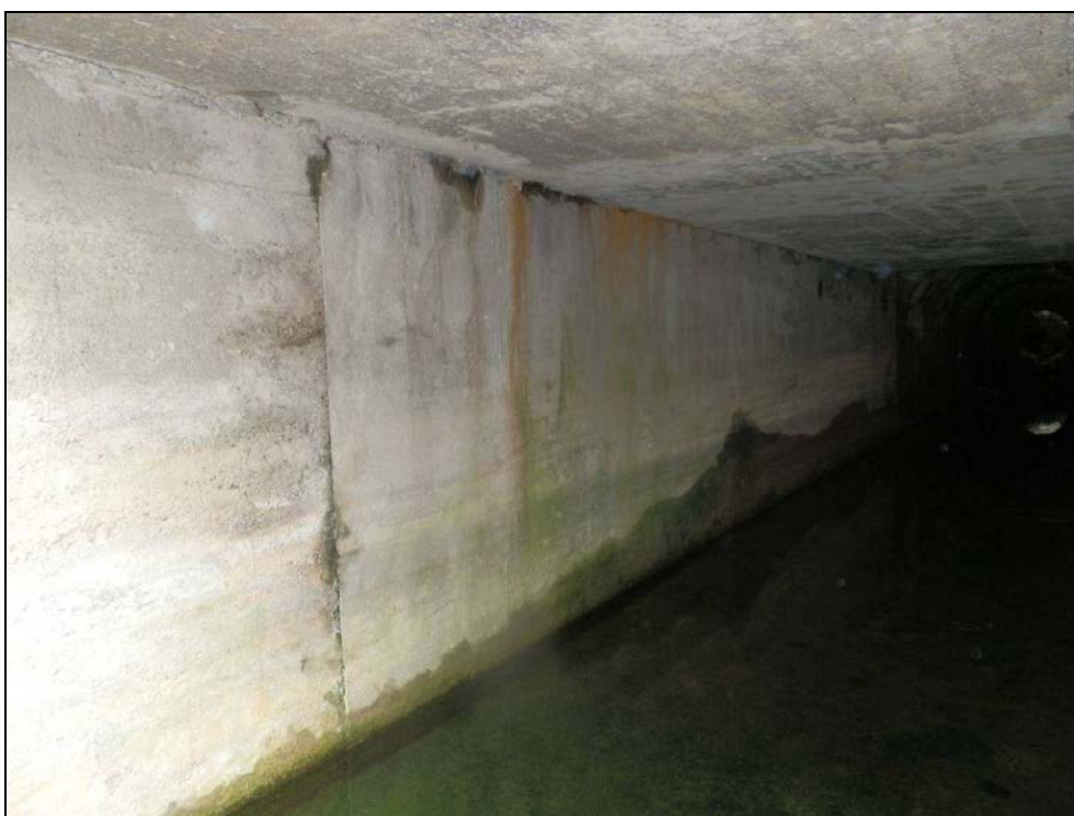
Obr. č. 2 - pohled na opěru Praha těsně za pravým čelem. Spodní stavba a je z monolitického betonu, povrch betonu je zachovalý, pouze s opady do 2-3 mm. Nosná konstrukce pravé části pod hlavními kolejemi je desková z vyztuženého betonu. Spárou nad úložným prahem místy zatéká, dále zatéká pracovními spárami.
